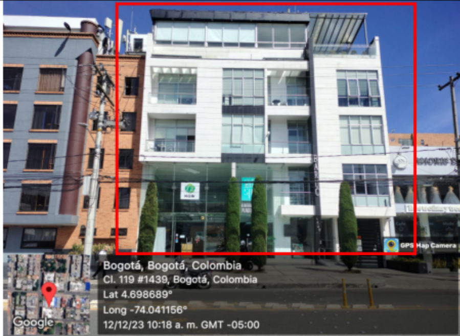
Foto panoramica del la edificación donde se encuentra ubicada la publicidad
